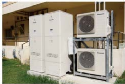
産業住宅に設置されたネットワーク型エコキュートは高熱調整と温水供給を兼ねる
