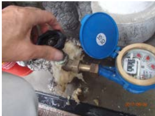
3部屋のメーター廻り配管を検証
