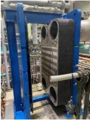
設置前 酸洗浄後一ヶ月でスケールが大量付着
