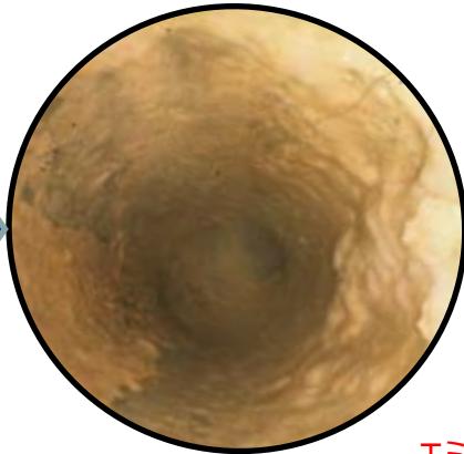
薬品洗浄後2ヶ月で尿石再付着
