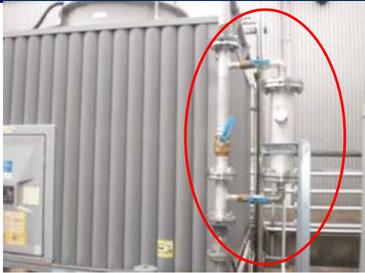
密閉型冷却塔にエミール取付け状況
