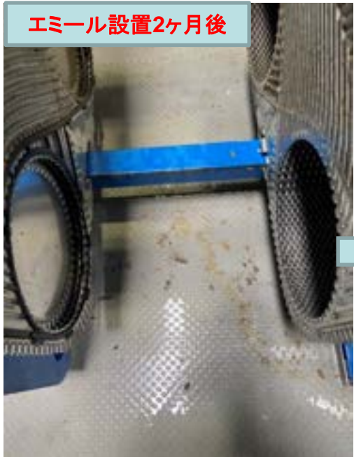
エミール設置後 開放時、スケール付着はほとんど確認されず！
