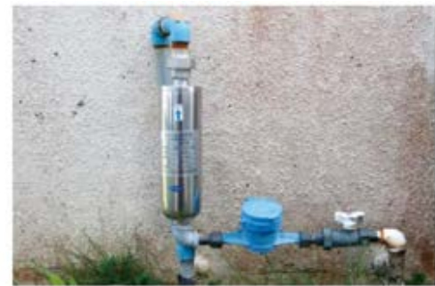
メーカーと協力して従来品特有のカルシウム結晶化によるエコキュートのパイプ目詰まりを防ぐ軟水器
